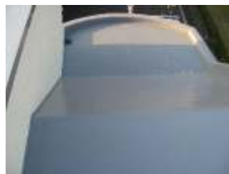
仕上げスロープ部
